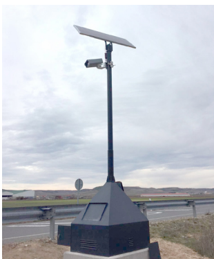
Cámara OCR en sistema Nomad del radar de tramo ubicado en CL-602.
